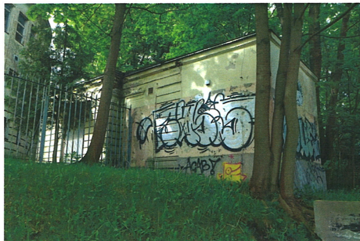
Widok budynku od strony północno-wschodniej
