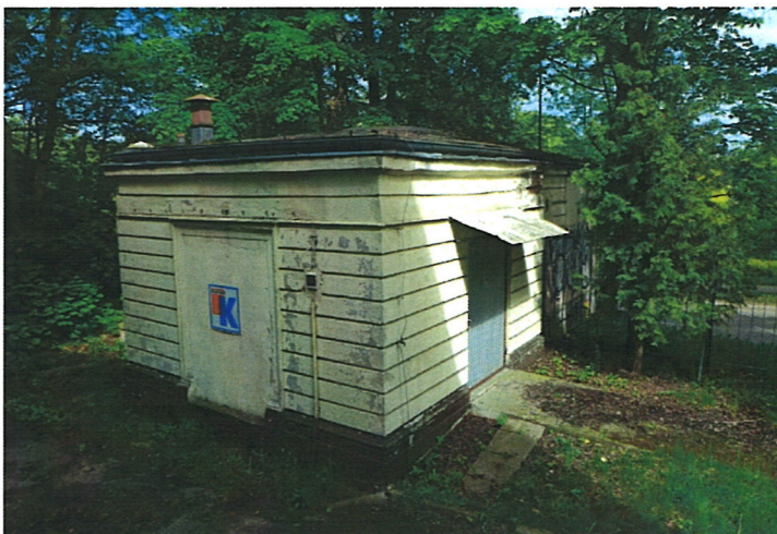
Widok budynku od strony południowo-wschodniej
