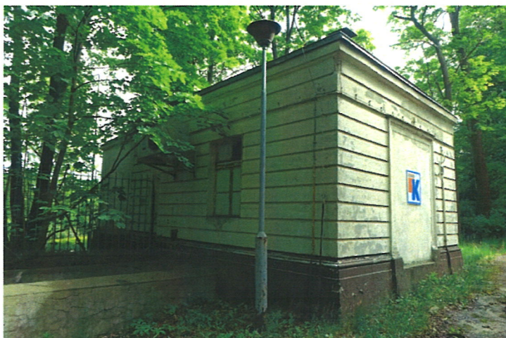
Widok budynku od strony południowo-zachodniej
