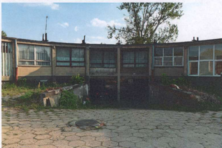
Fragment elewacji tylnej pawilonu (od strony dziedzińca wewn.)
