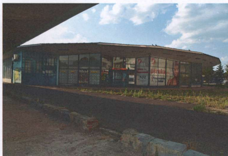
Widok ogólny pawilonu od strony północno-wschodniej
