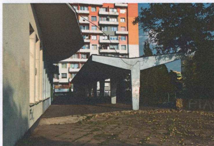
Widok ogólny wiaty przy pawilonie od strony północno-zachodniej
